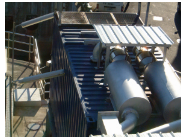
貨櫃式發電機加裝觸媒排煙淨化器解決了困擾
