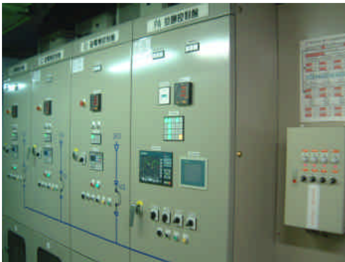
新系統為 ComAp IG-NT 數位式發電機並聯盤
