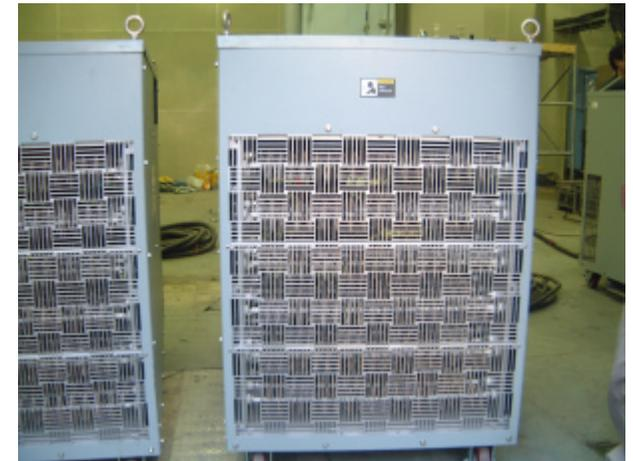
美製 AVTRON 連續使用型電阻性負載器
