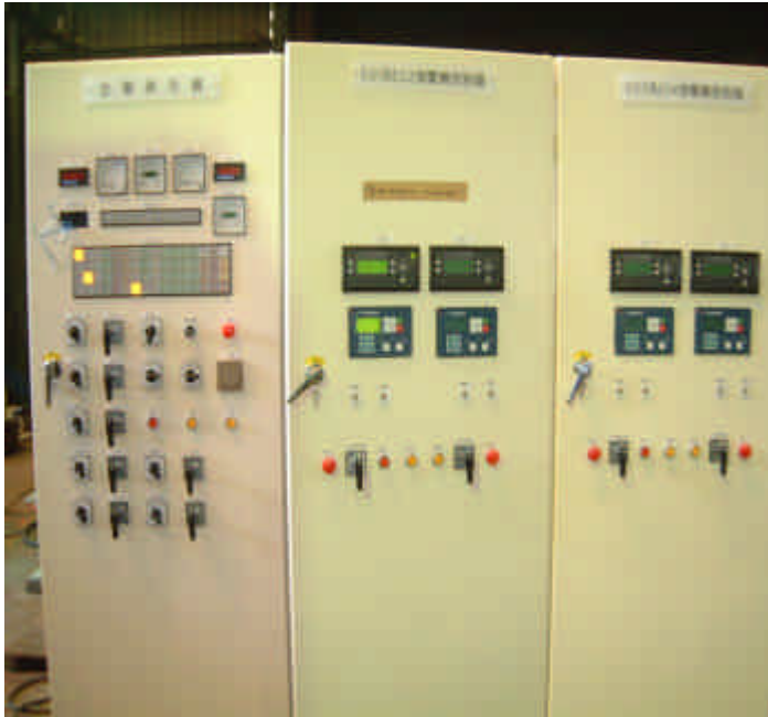
發電機四台並聯控制盤 IG-CU SPM 控制模式+DEIF GPC 並聯控制
