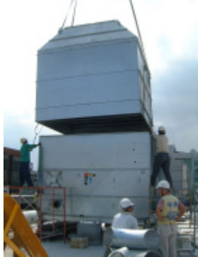
上座散熱灑水系統
