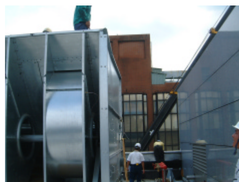
下座冷水盤暨離心式馬達風扇
