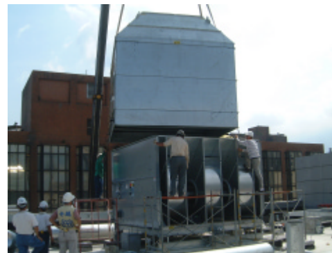
大型冷卻水塔吊裝定位工程
