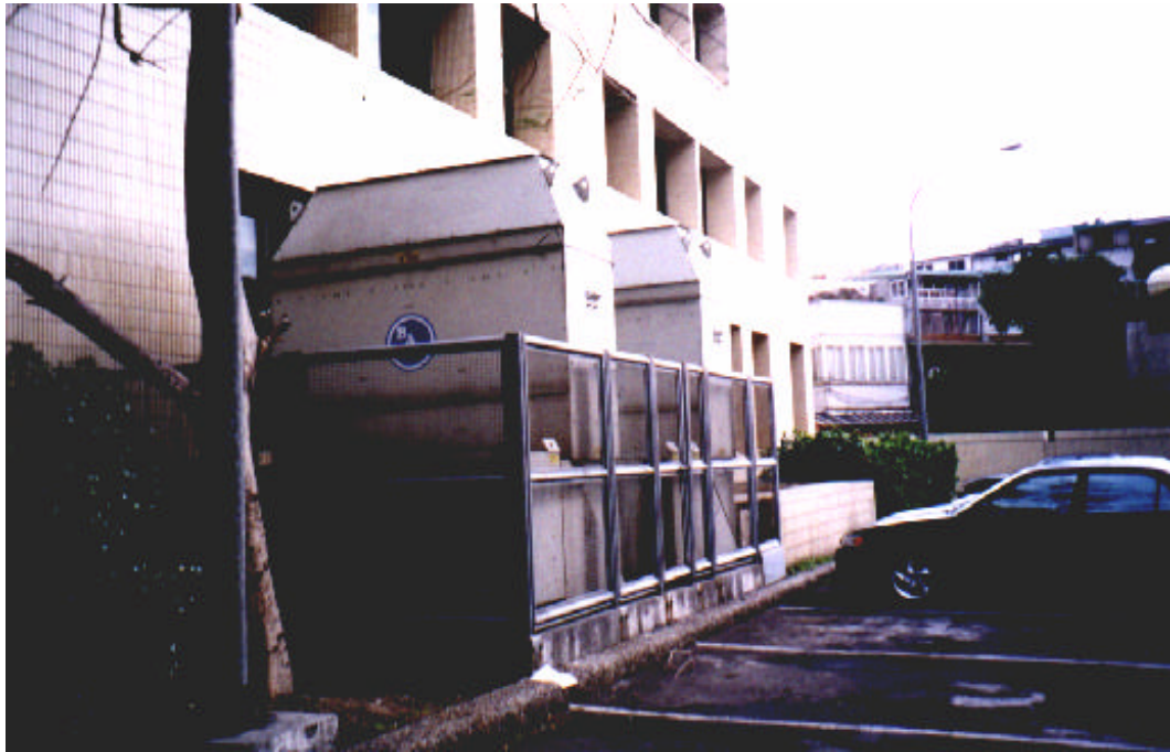
方型結構不佔空間，單側進風可利用建築物剩餘空間及方向擺設。
