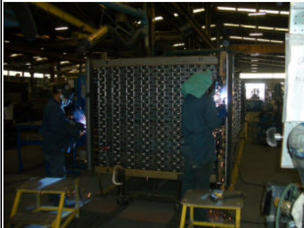
Header A 焊接
